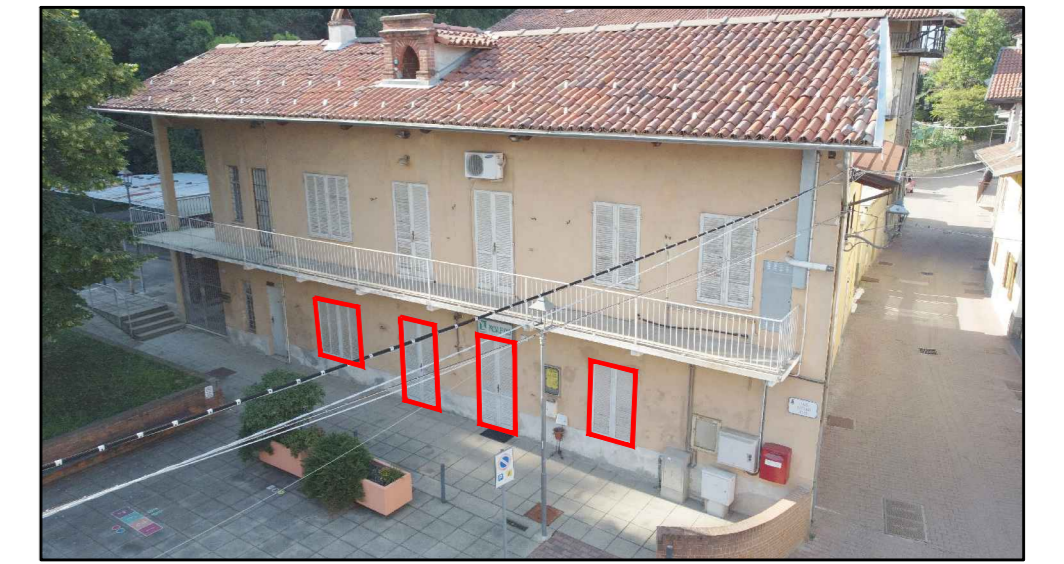
VISTA LATO PIAZZA
